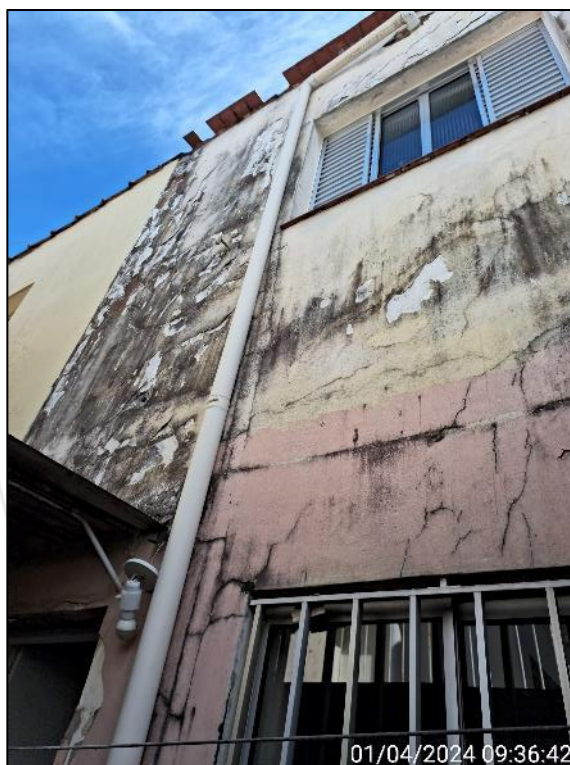
Foto 16. Vista da fachada posterior do imóvel avaliando.
