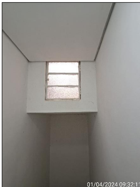
Foto 11. Detalhe do teto nas escadas.
