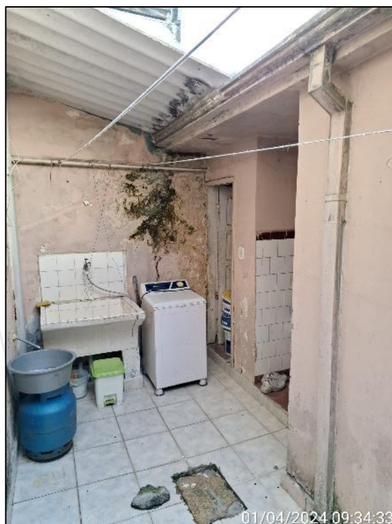
Foto 14. Vista da área de serviço.
