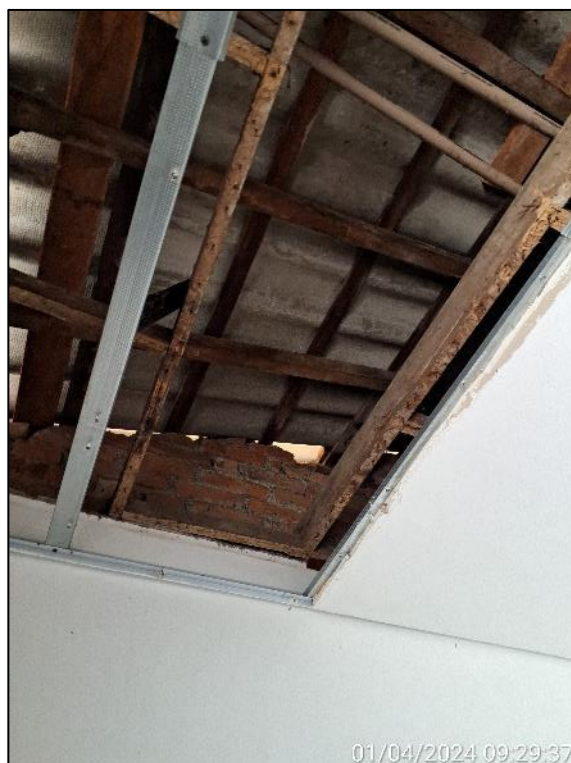
Foto 07. Detalhe do teto do dormitório 02.
