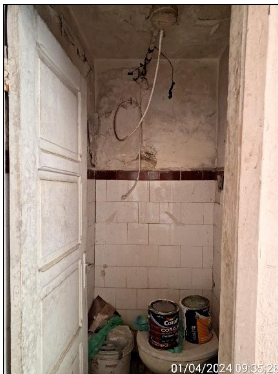
Foto 15. Vista do banheiro de empregado.
