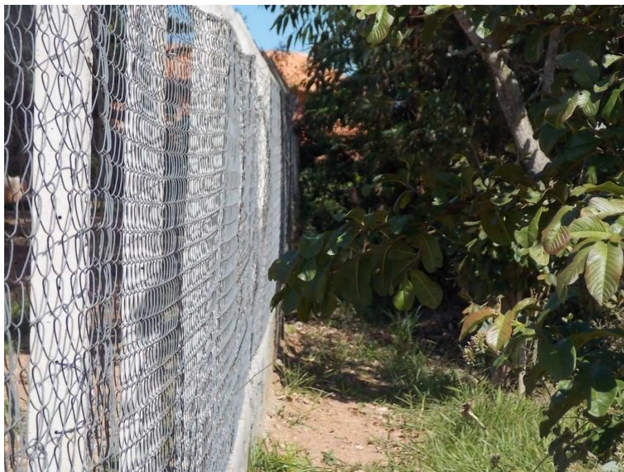
Vistas da cerca de divisa dos lotes (olhando de frente, lado esquerdo).
