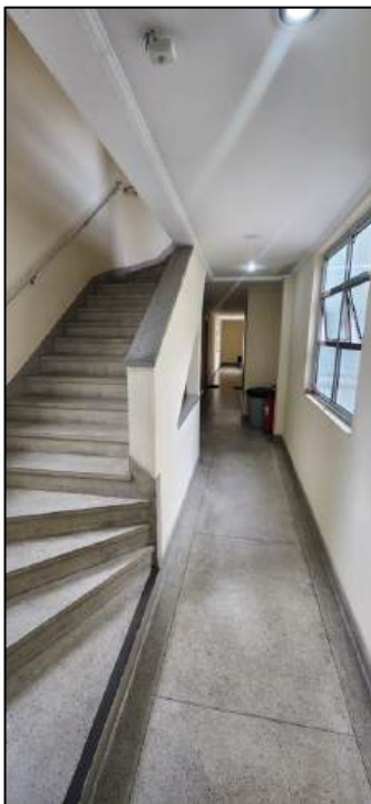
Foto 03 – Escada de acesso
