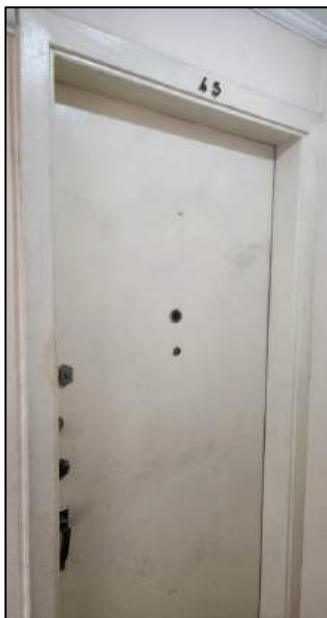
Foto 04 – Hall no andar
