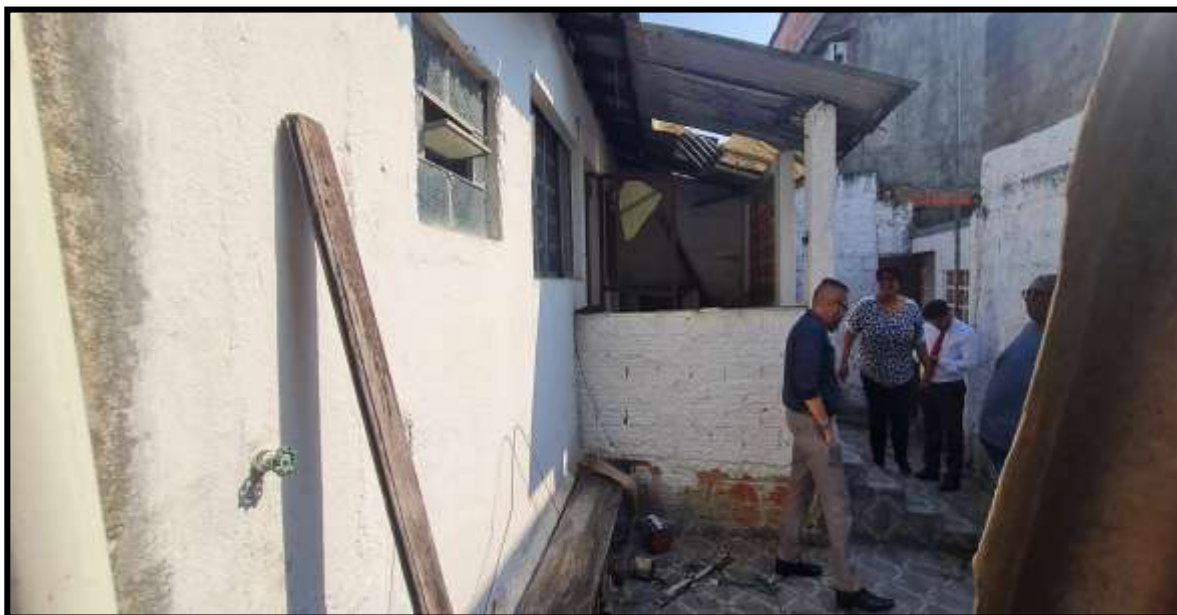
12. Edificação dos fundos do terreno.
