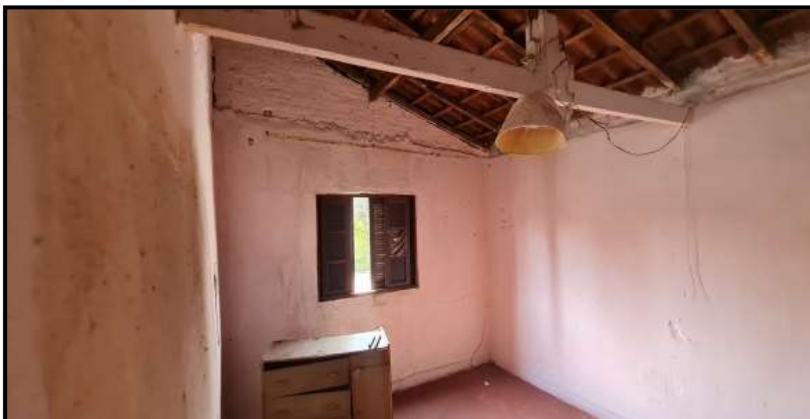
3. Edificação Principal. Vista de um dos dormitórios.
