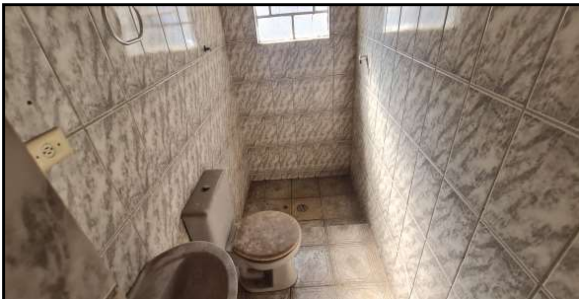
16. Edificação dos fundos do terreno. Vista interna do banheiro.
