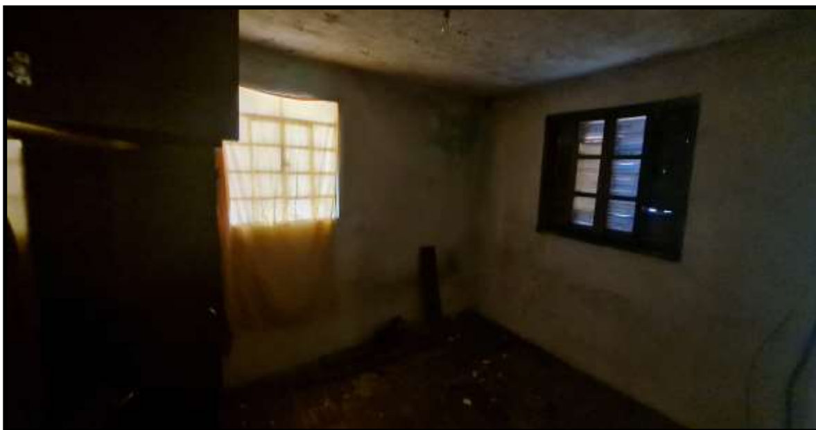
11. Vista interna da edificação intermediária. Dormitório.
