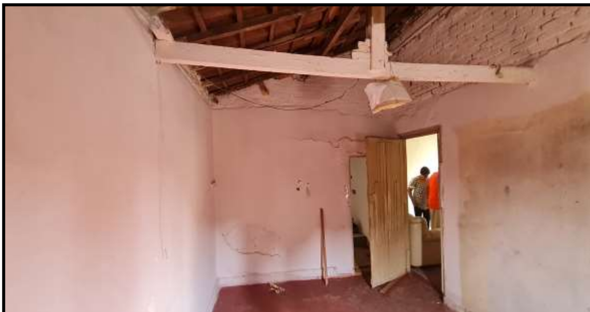
6. Edificação Principal. Vista do dormitório da foto 3.
