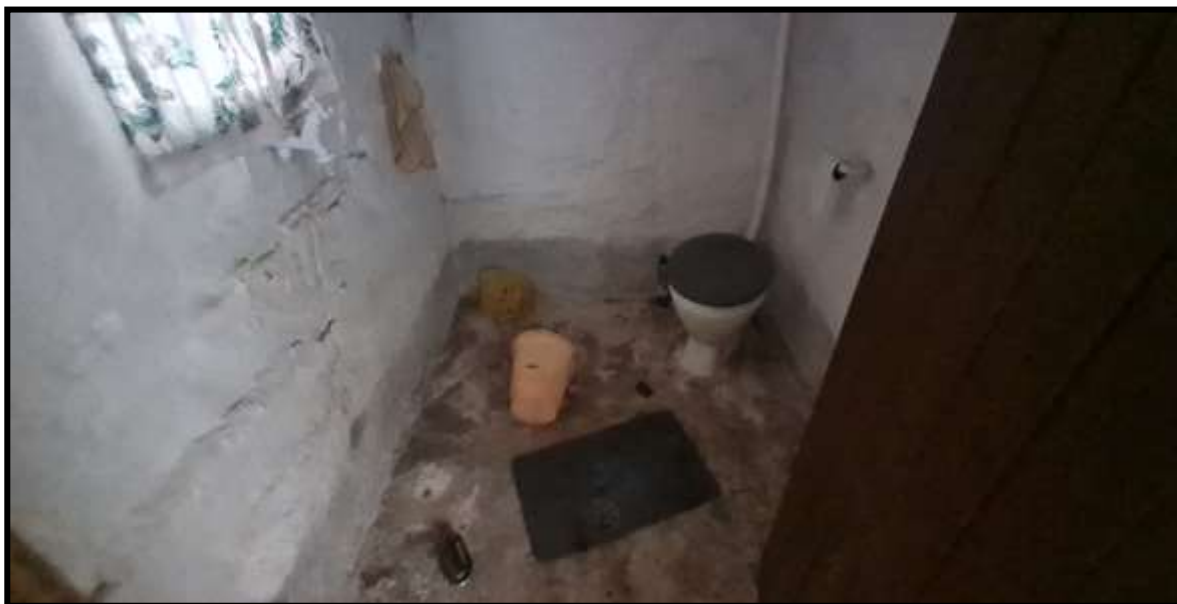
4. Edificação Principal. Vista interna do banheiro.
