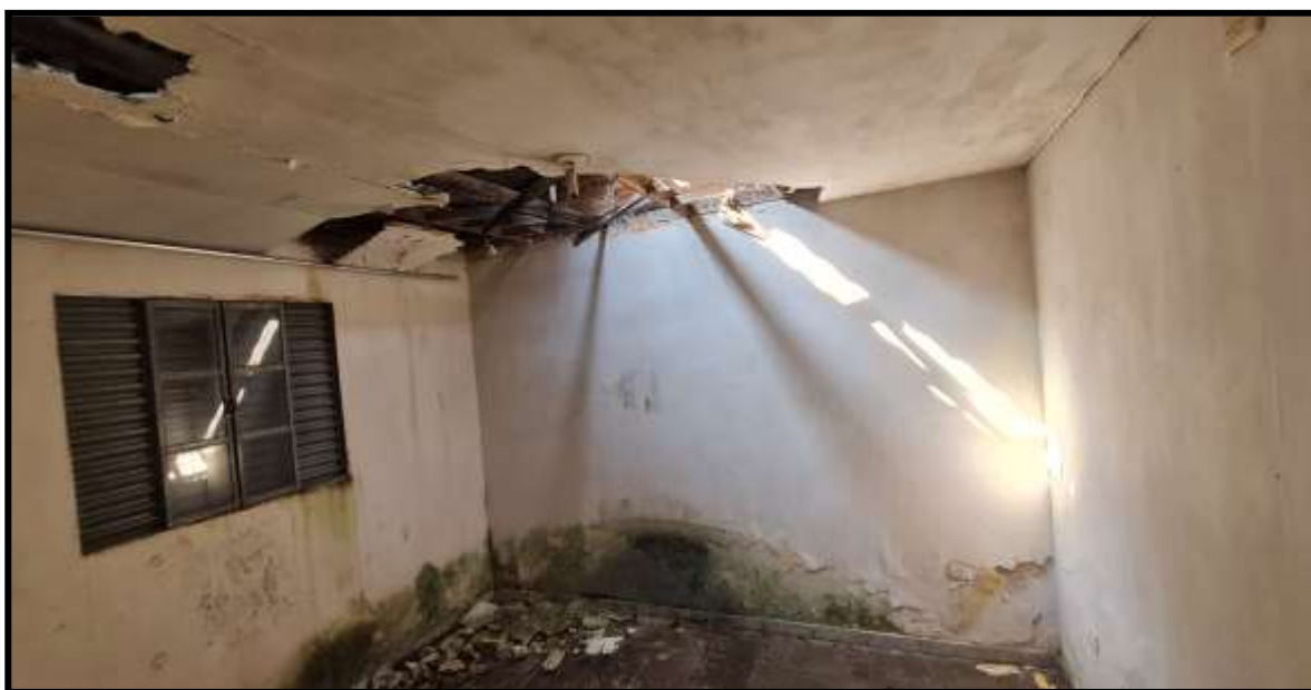
15. Edificação dos fundos do terreno. Nova vista do dormitório.
