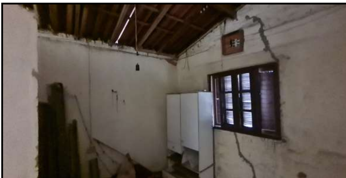
5. Edificação Principal. Vista de outro dormitório.
