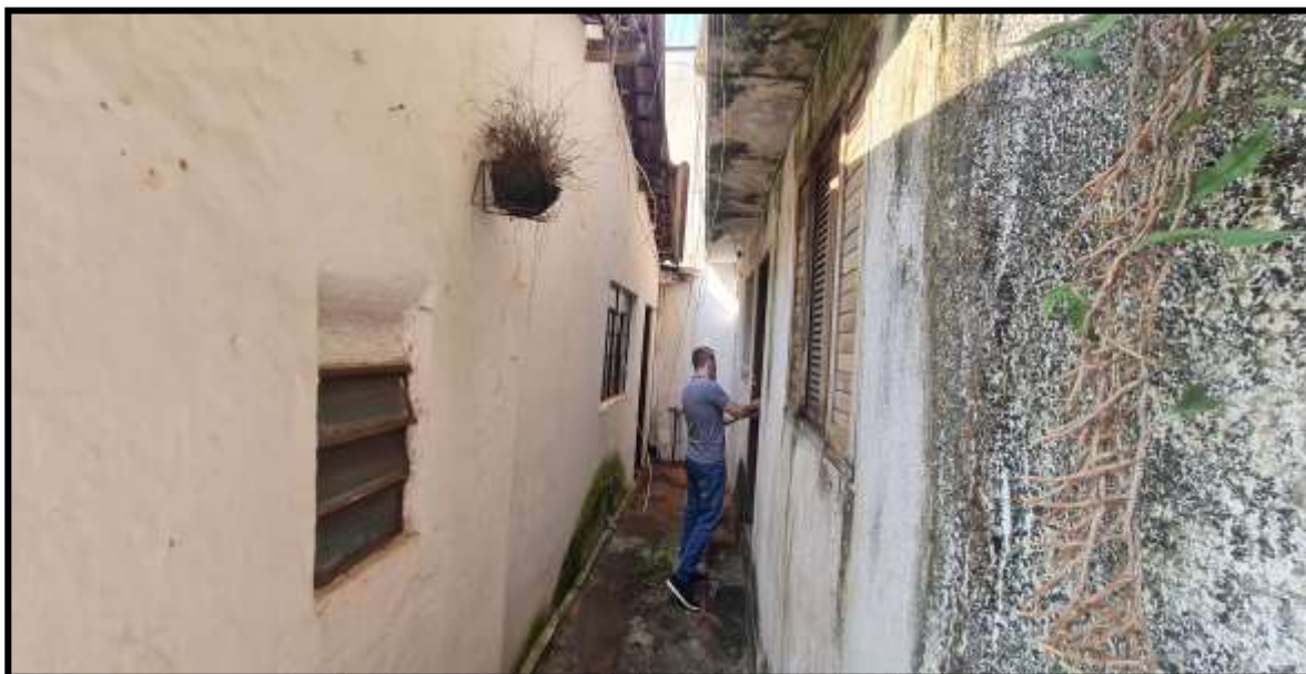
8. Vista da fachada da edificação intermediária.
