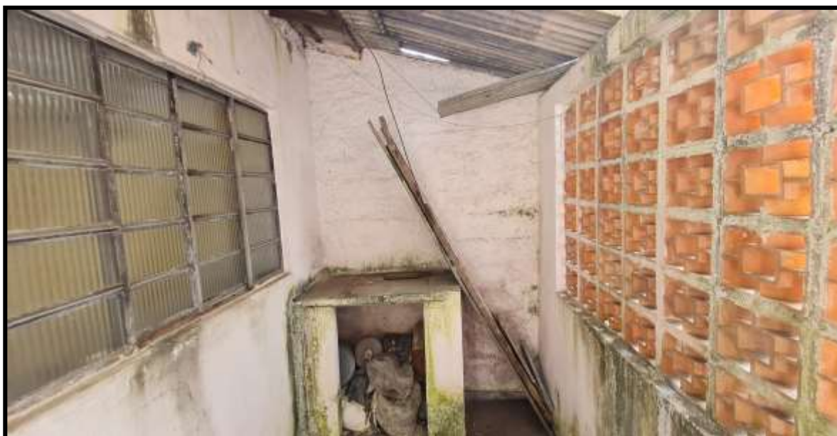
13. Edificação dos fundos do terreno. Vista da varanda.
