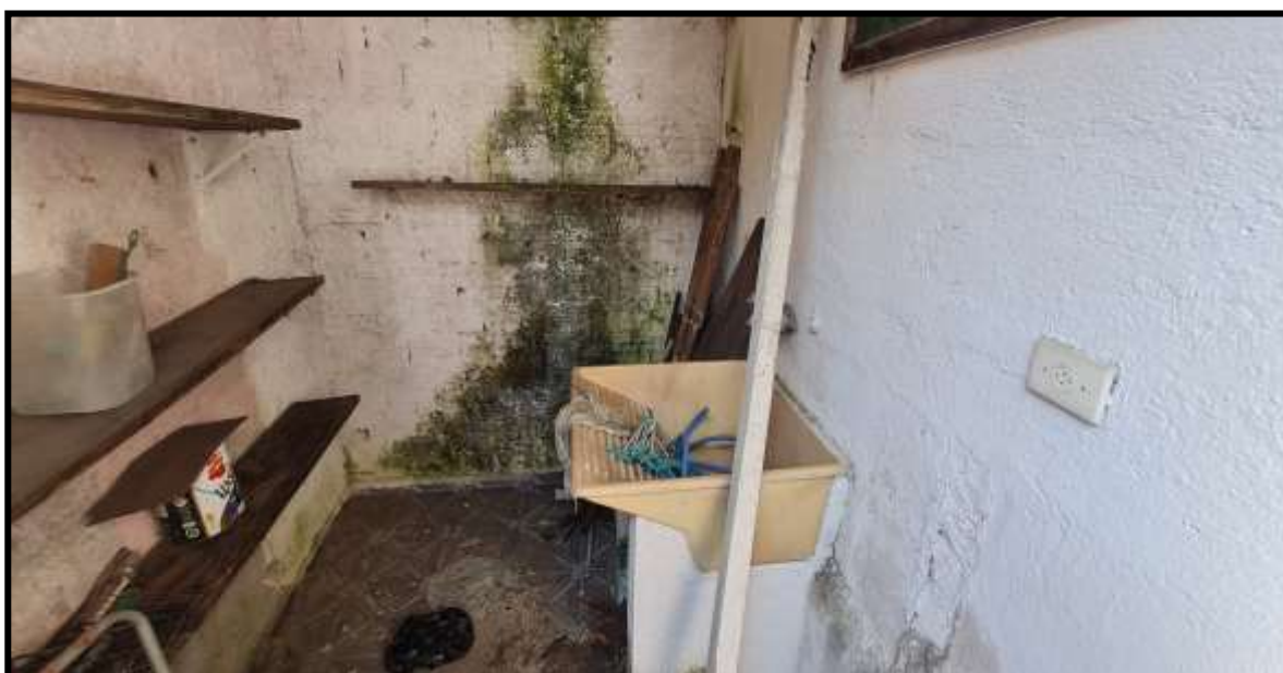
17. Edificação dos fundos do terreno. Área vdo tanque.
