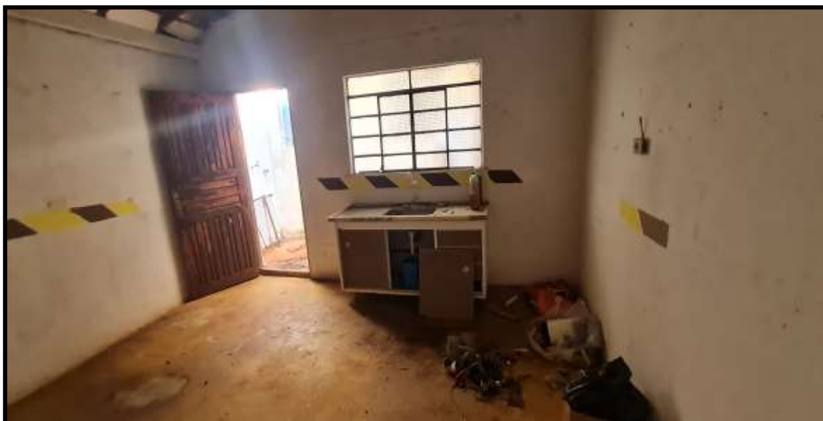
7. Edificação Principal. Vista da cozinha.
