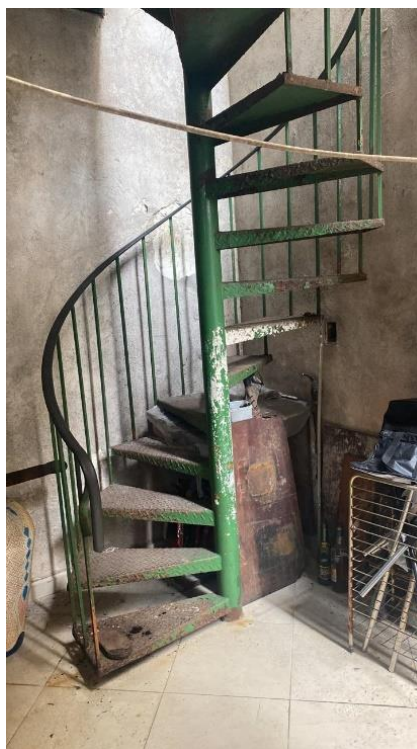
Foto 45 – Escada de acesso á área de serviço
