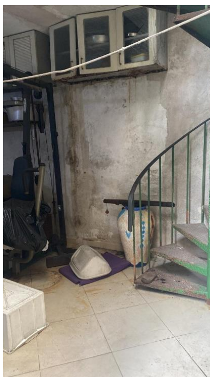
Foto 44 – Escada de acesso à área de serviço
