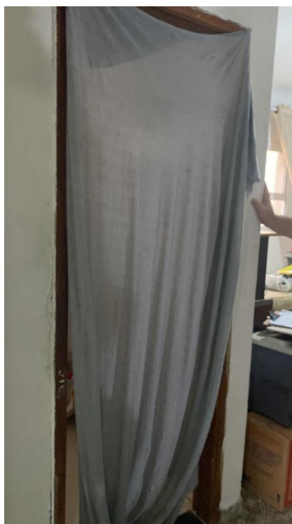
Foto 18 – Porta do banheiro nº2
