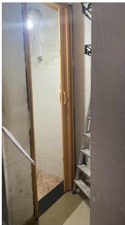
Foto 9 – Porta do banheiro nº1
