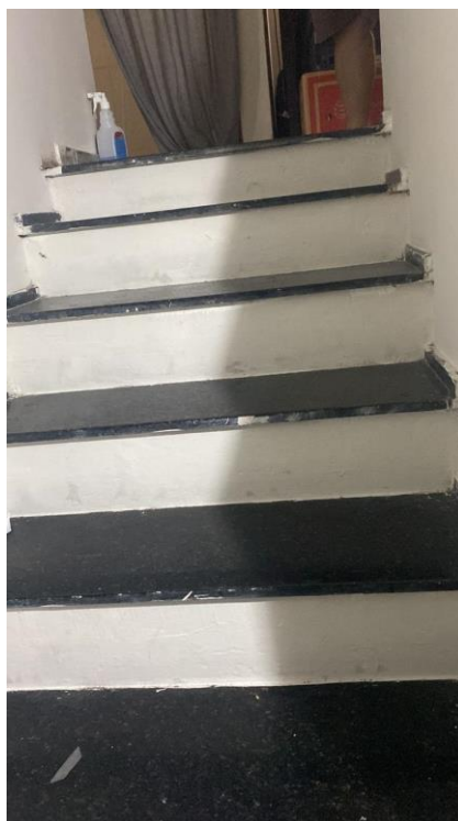
Foto 17 – Segunda parte da escada de acesso ao 1º piso
