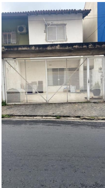
Foto 1 – Fachada da residência
