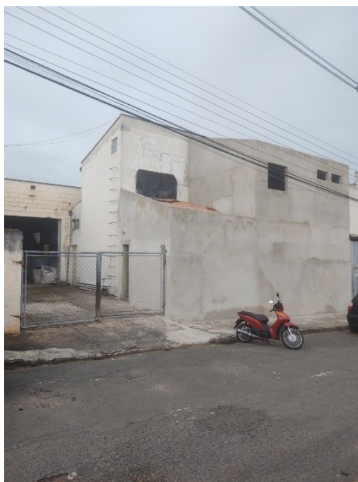
Foto 01 - Vista parcial externa do imóvel sub-judice
