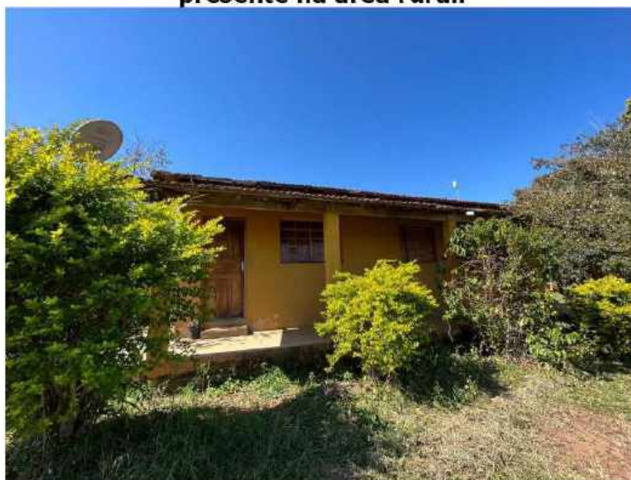
Imagem 21 – Vista da área Rural (Matrícula 2.131), com área de 158.180 m 2 m 2 / Estrada Carlos Canhassi s/nº - Bairro dos Leais, "Haras Terix" Serra Negra – SP / Vista da residência presente na área rural.
