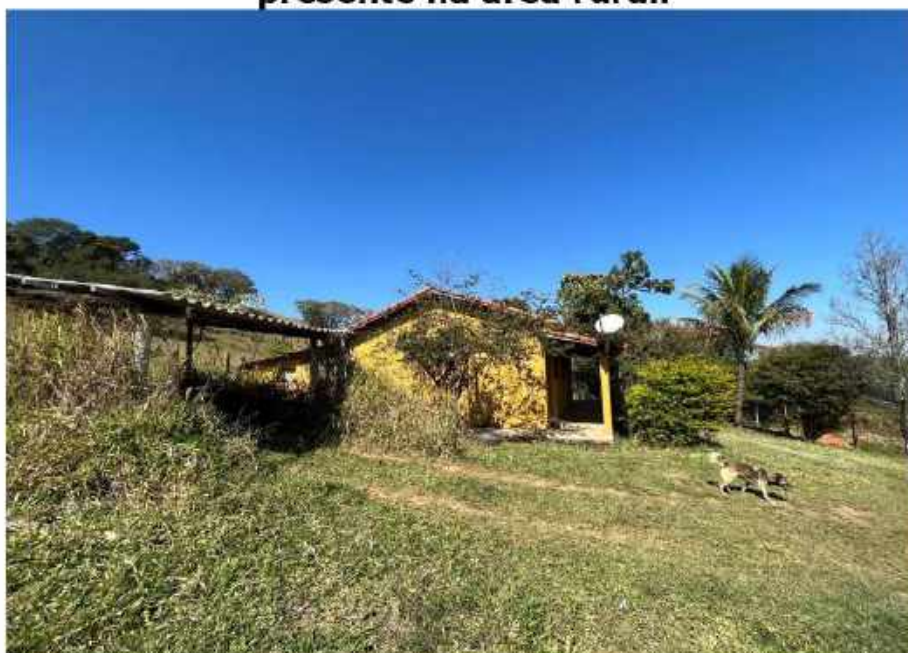
Imagem 19 – Vista da área Rural (Matrícula 2.131), com área de 158.180 m 2 / Estrada Carlos Canhassi s/nº - Bairro dos Leais, "Haras Terix" Serra Negra – SP / Vista da residência presente na área rural.
