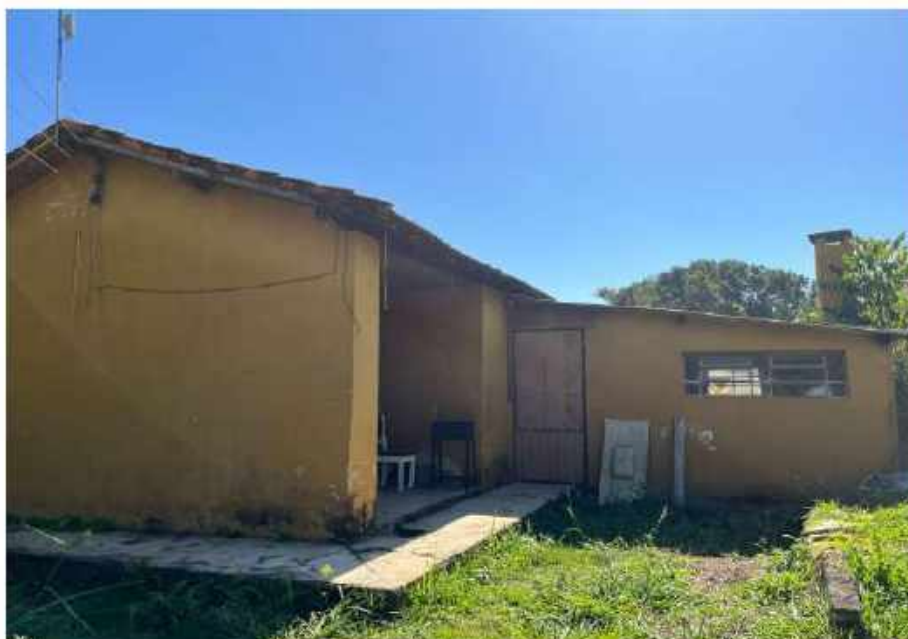
Imagem 24 – Vista da área Rural (Matrícula 2.131), com área de 158.180 m 2 m 2 / Estrada Carlos Canhassi s/nº - Bairro dos Leais, "Haras Terix" Serra Negra – SP / Vista da residência presente na área rural.
