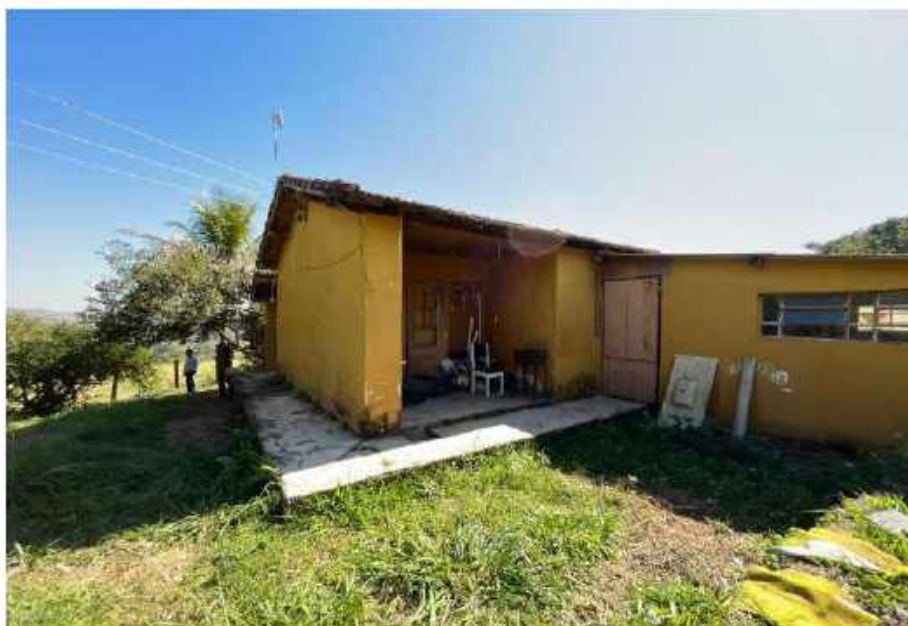
Imagem 26 – Vista da área Rural (Matrícula 2.131), com área de 158.180 m2 m2 / Estrada Carlos Canhassi s/nº - Bairro dos Leais, "Haras Terix" Serra Negra – SP / Vista da residência presente na área rural.
