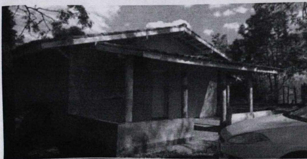
Foto 3: Fachada da casa nº 01.
