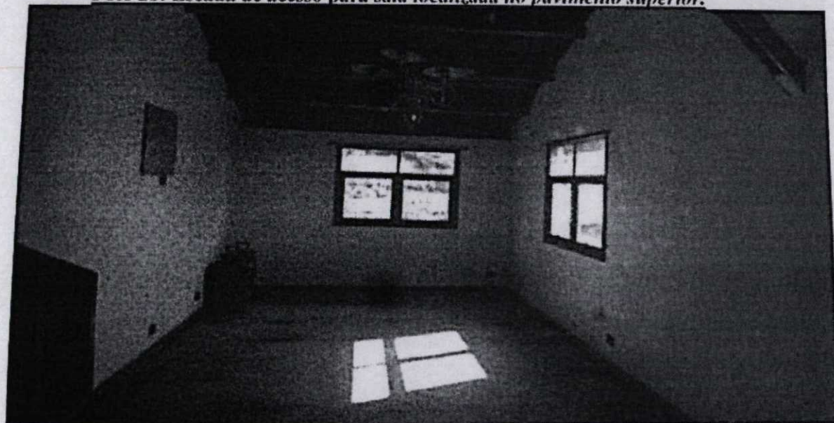
Foto 29: Sala localizada no pavimento superior.
