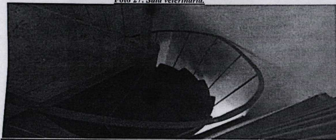
Foto 28: Escada de acesso para sala localizada no pavimento superior.
