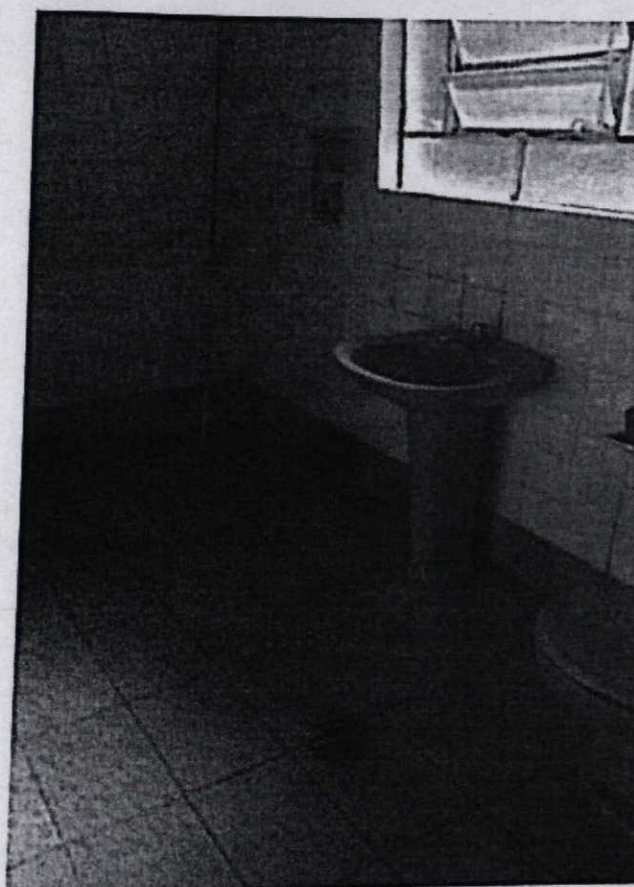
Foto 7: Banheiro casa n° 02.
