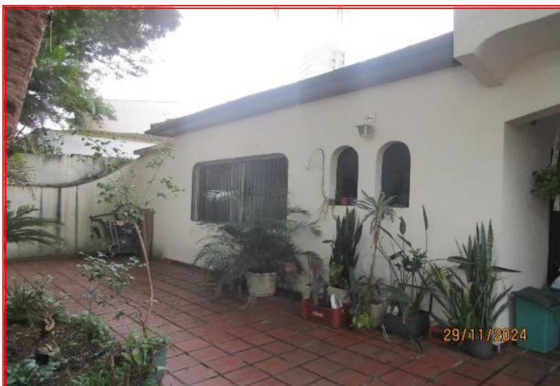
Foto nº 05: Vista geral da parte frontal descoberta.
