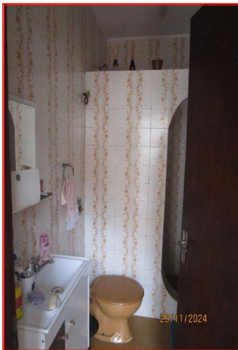
Foto nº 25: Vista parcial do banheiro.
