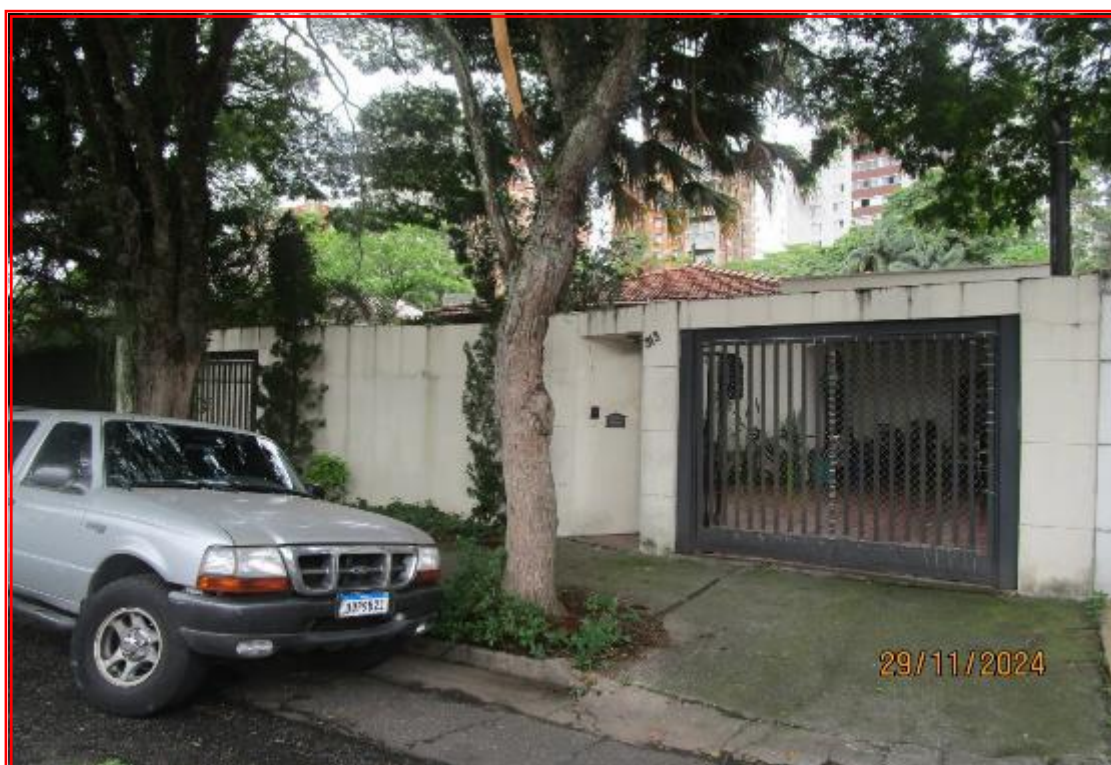
Foto nº 04: Outra vista geral da fachada do imóvel avaliando.
