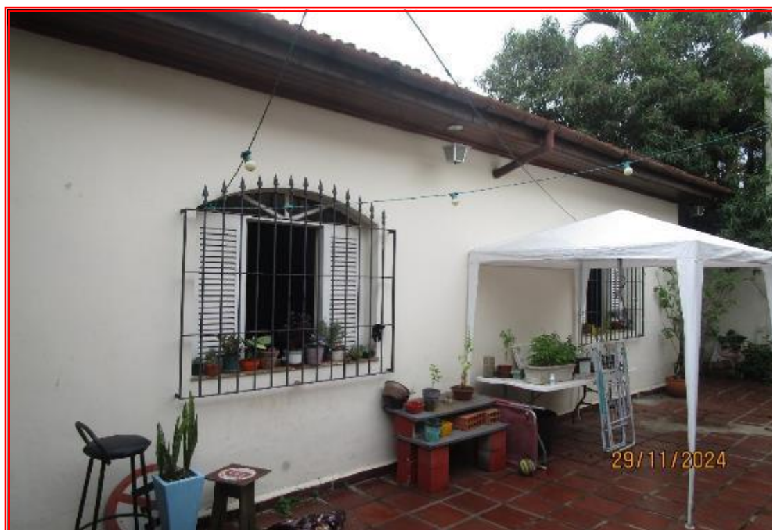
Foto nº 19: Vista geral da fachada posterior do corpo principal.
