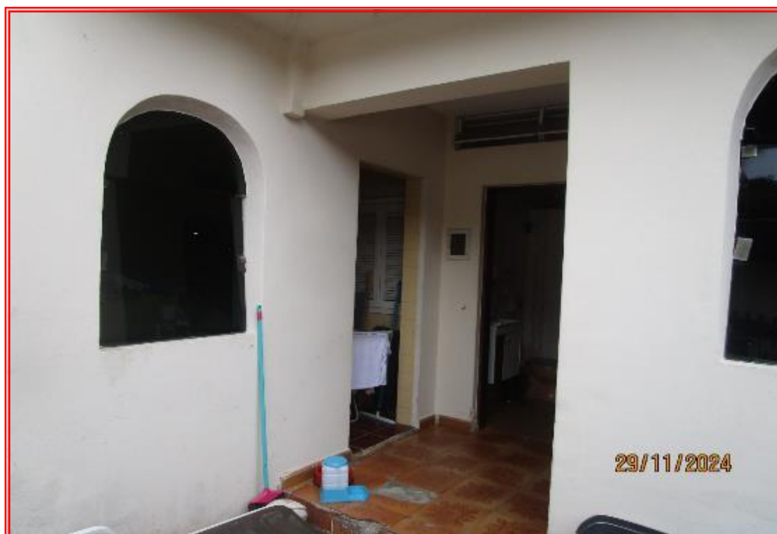
Foto nº 24: Vista do acesso ao banheiro e área de serviço.
