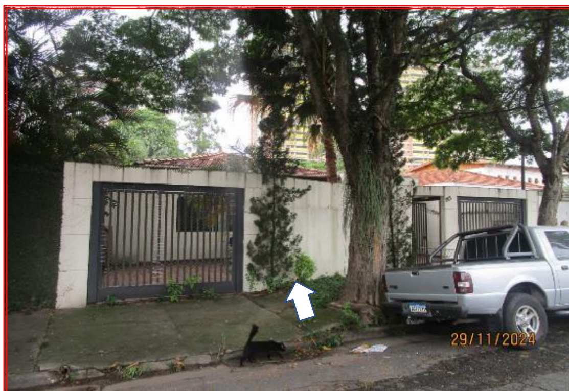
Foto nº 03: Vista geral da fachada do imóvel avaliando.
