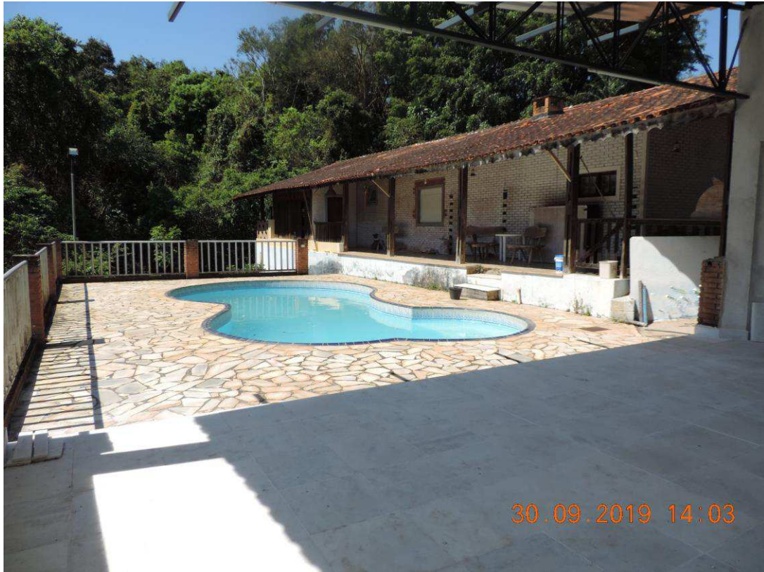
FOTO Nº 17 – VISTA INTERNA DA PROPRIEDADE
