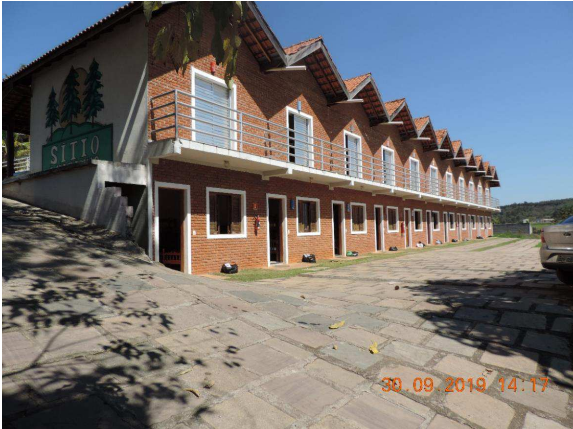
FOTO Nº 41 – VISTA INTERNA DA PROPRIEDADE
