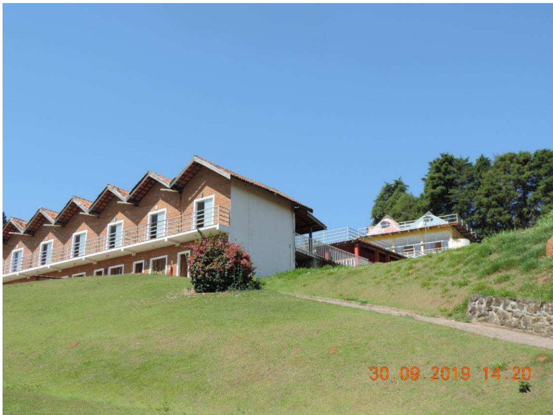
FOTO Nº 46 – VISTA INTERNA DA PROPRIEDADE
