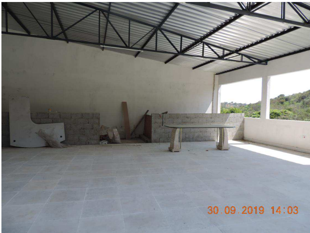
FOTO Nº 18 – VISTA INTERNA DA PROPRIEDADE
