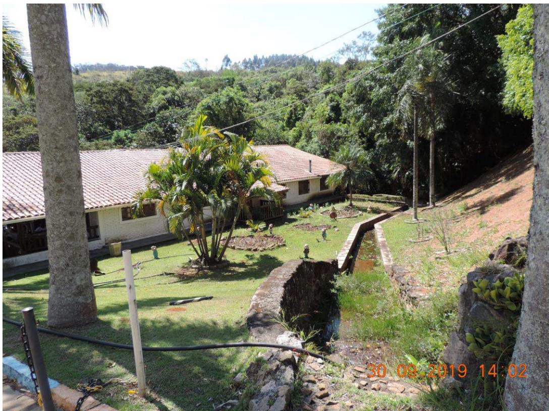
FOTO Nº 16 – VISTA INTERNA DA PROPRIEDADE
