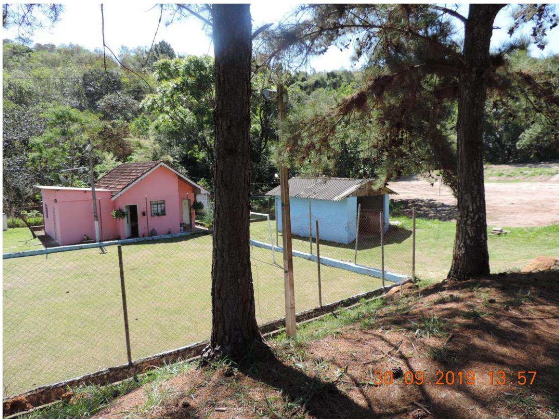
FOTO Nº 10 – VISTA INTERNA DA PROPRIEDADE
