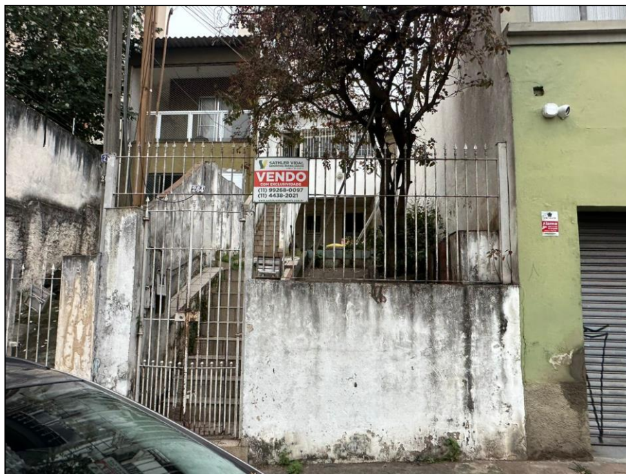
Vista da frente do imóvel avaliando.
