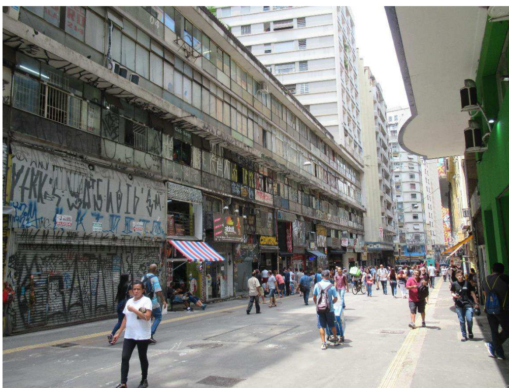
Foto nº. 5 – Vista parcial das lojas localizadas no pavimento térreo do conjunto.
