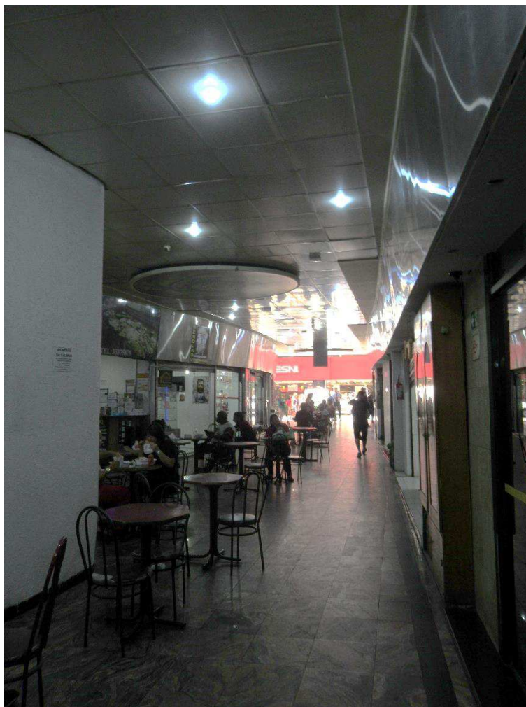
Foto nº. 8 – Outra vista parcial da galeria.
