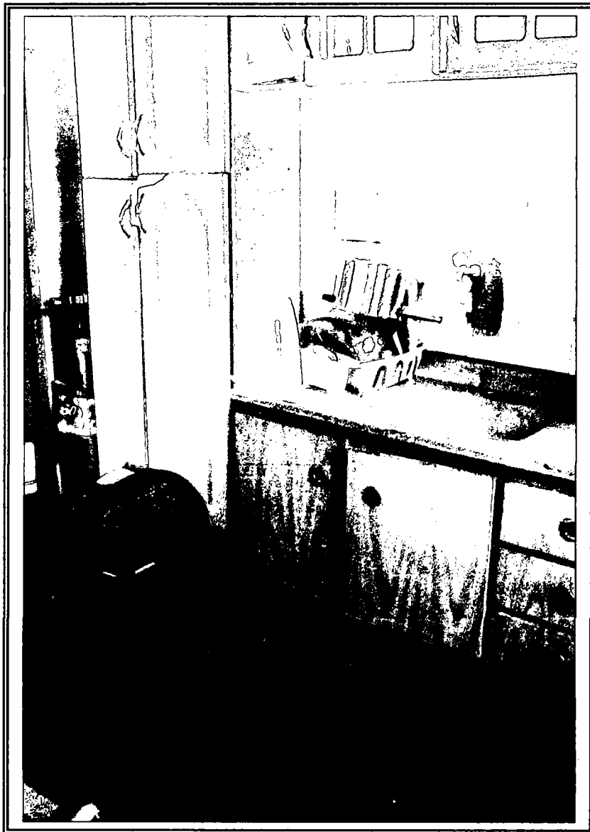
Foto nº 10: Vista da cozinha. Suas principais características construtivas são: piso cimentado, paredes revestidas em massa pintadas em látex, forro em madeira e esquadrias de ferro.
