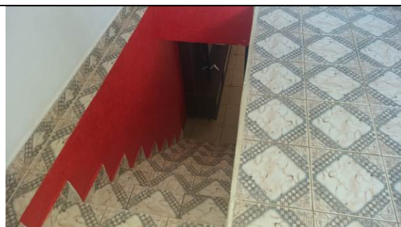
Vista da escada de ligação dos 2 pavimentos.
