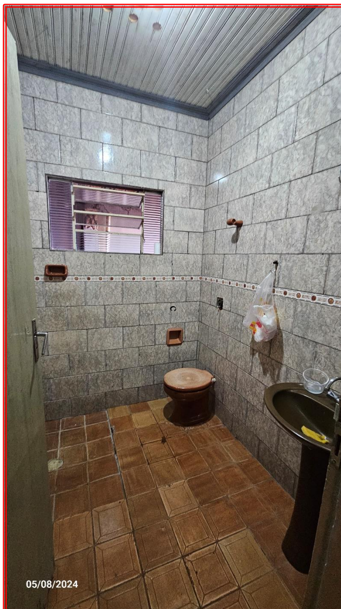
Foto 04: Aspecto geral do banheiro.
