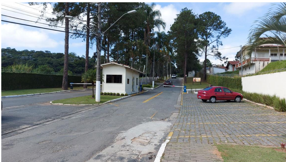
FOTO 9 – Vista da portaria do Condomínio Arujazinho I, II, III.
