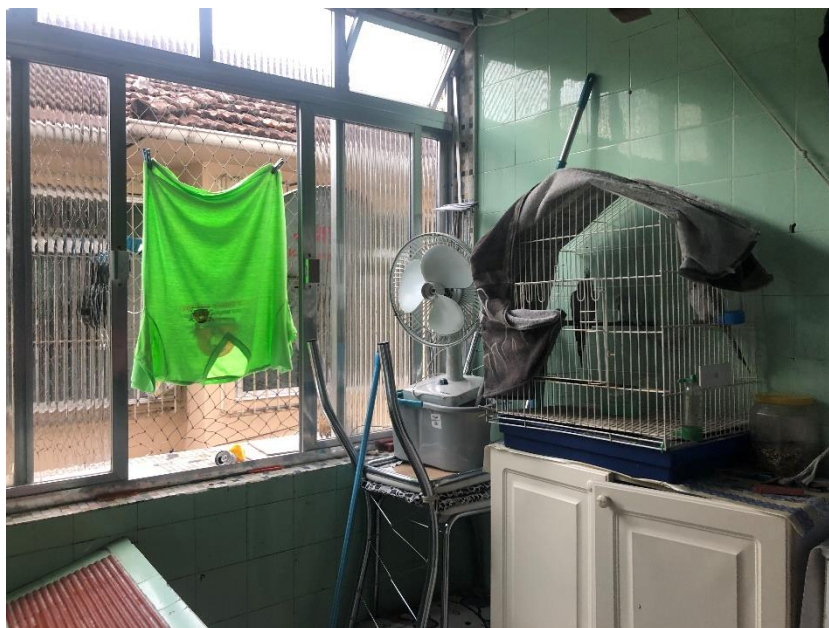
Foto 03 – Vista da cozinha. Suas principais características construtivas são: piso cerâmico, paredes azulejadas até o teto, forro em laje e esquadrias de alumínio.
