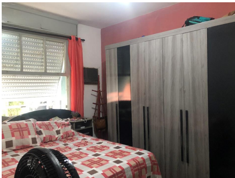
Foto 07 – Vista de outro dormitório. Suas principais características construtivas são: piso cerâmico, paredes revestidas em massa corrida pintadas em látex, forro em laje e esquadrias de alumínio.
